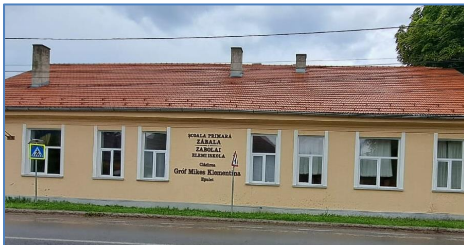
A zabolai elemi iskola, gróf Mikés Klementina Épület (saját felvétel, 2022.08.20.)
